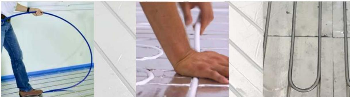
Il faut être vigilant à ne pas plier le tube lors de sa mise en place. Si c'est le cas, la boucle endommagée doit alors être réparée ou remplacée, car lors de la mise en eau, il peut y avoir des fuites soit immédiatement, soit dans un futur proche
